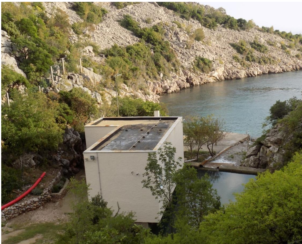
Slika 2.6. Objekat vodocrpilišta Bačvice sa sabirnim bazenom
