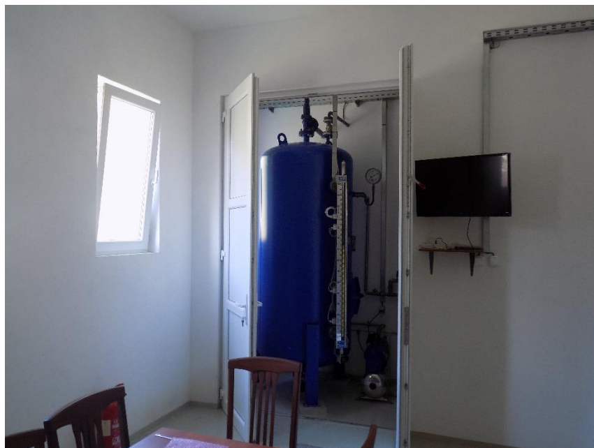
Slika 2.7. Objekat vodocrpilišta Bačvice, postrojenje za dezinfekciju vode
