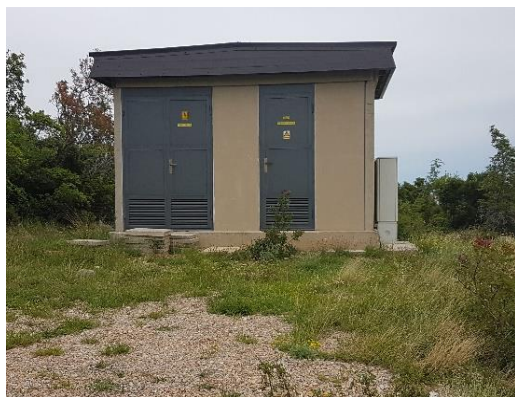
Slika 8.4.2. Trafostanica Bačvice-Stari Porat
