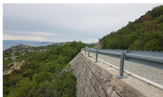
Slika 8.2.7. Pogled na potporni zid i zaštitnu ogradu magistralu iz pravca juga
