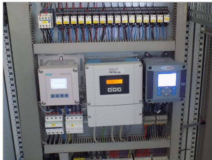
Slika 2.9. Kontrolna ploča sustava za upravljanje na vodocrpilištu Bačvice
