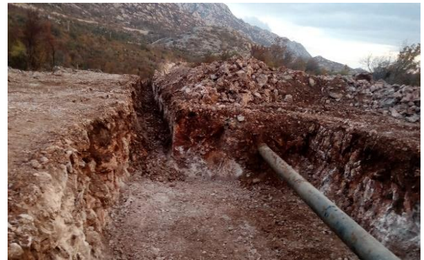
Slika 8.3.2 Izgradnja transportnog cjevovoda Stinica-Bačvice gdje se vidi stari cjevovod i novi
