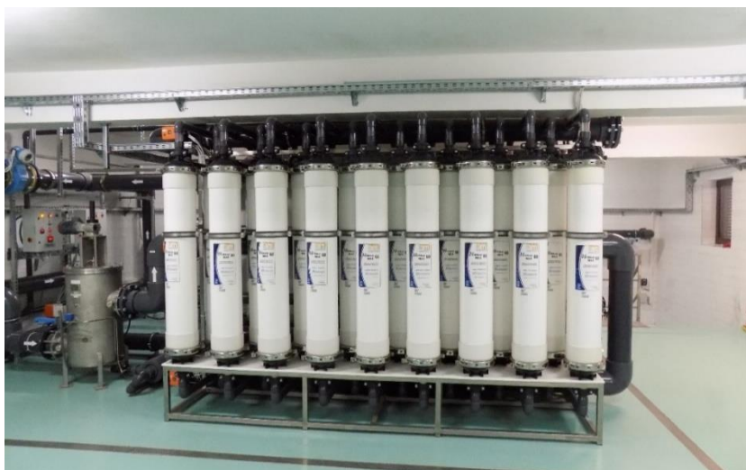
Slika 2.5. Postrojenje za filtraciju na lokaciji Hrmotine
