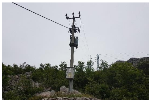
Slika 8.4.4. Stupna trafostanica Podić
