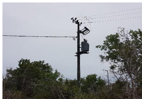
Slika 8.4.5. Stupna trafostanica Bačvice
