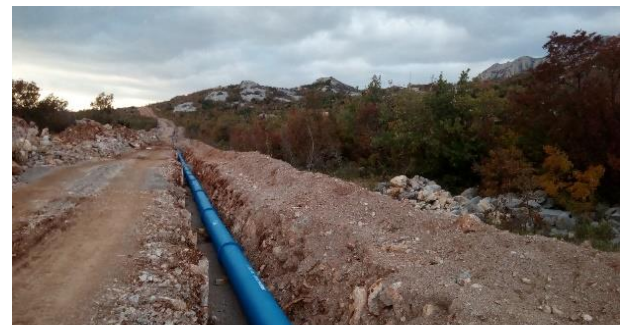
Slika 8.3.2 Izgradnja transportnog cjevovoda Stinica-Bačvice gdje se vidi stari cjevovod i novi
