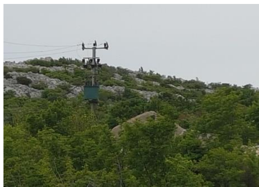
Slika 8.4.3. Stupna trafostanica Kalići
