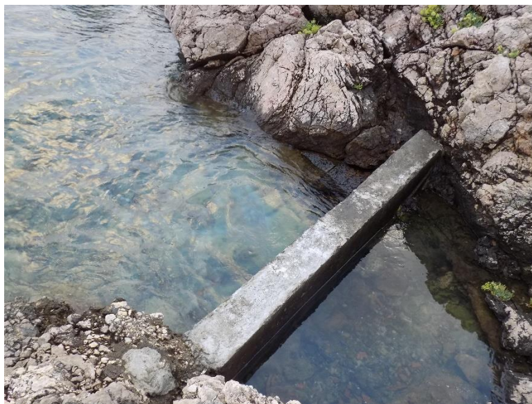
Slika 4.9. Primitivno kaptiran izvor u dnu uvale Bačvice (15.10.2016.)
