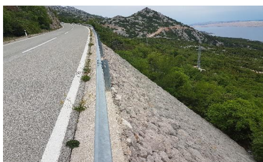
Slika 8.2.6. Pogled na potporni zid i zaštitnu ogradu magistralu iz pravca sjevera
