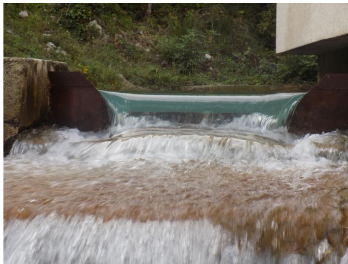
Slika 5.4.2. Trapezni oštrobridni preljev na izvoru Bačvice
