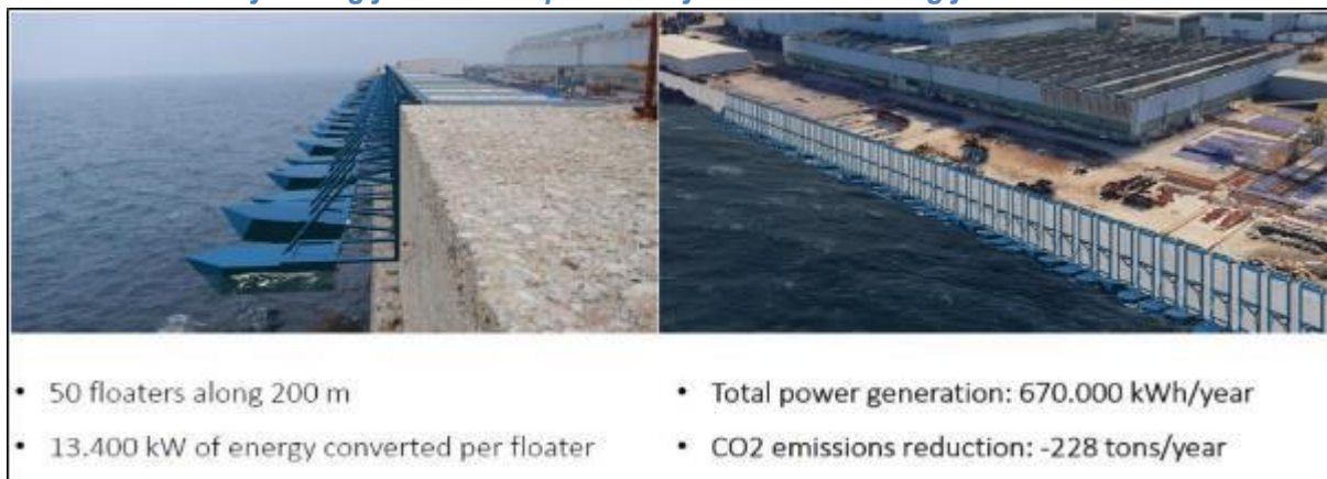
Slika 34: Korištenje energije valova za proizvodnju električne energije – Luka Ancona
