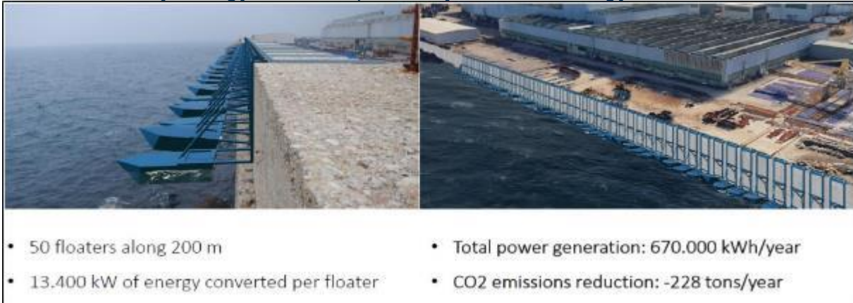
Slika 34: Korištenje energije valova za proizvodnju električne energije – Luka Ancona
