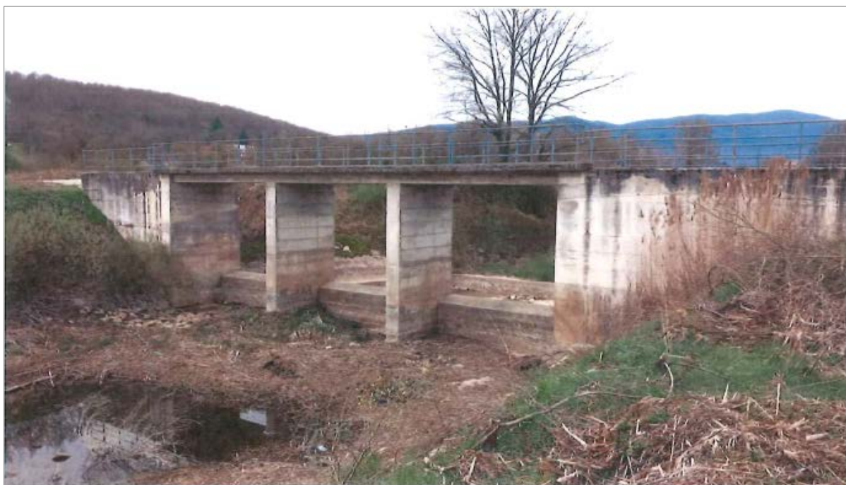
Slika 5. Pogled na pregradni prag i kolni prijelaz s uzvodne strane
