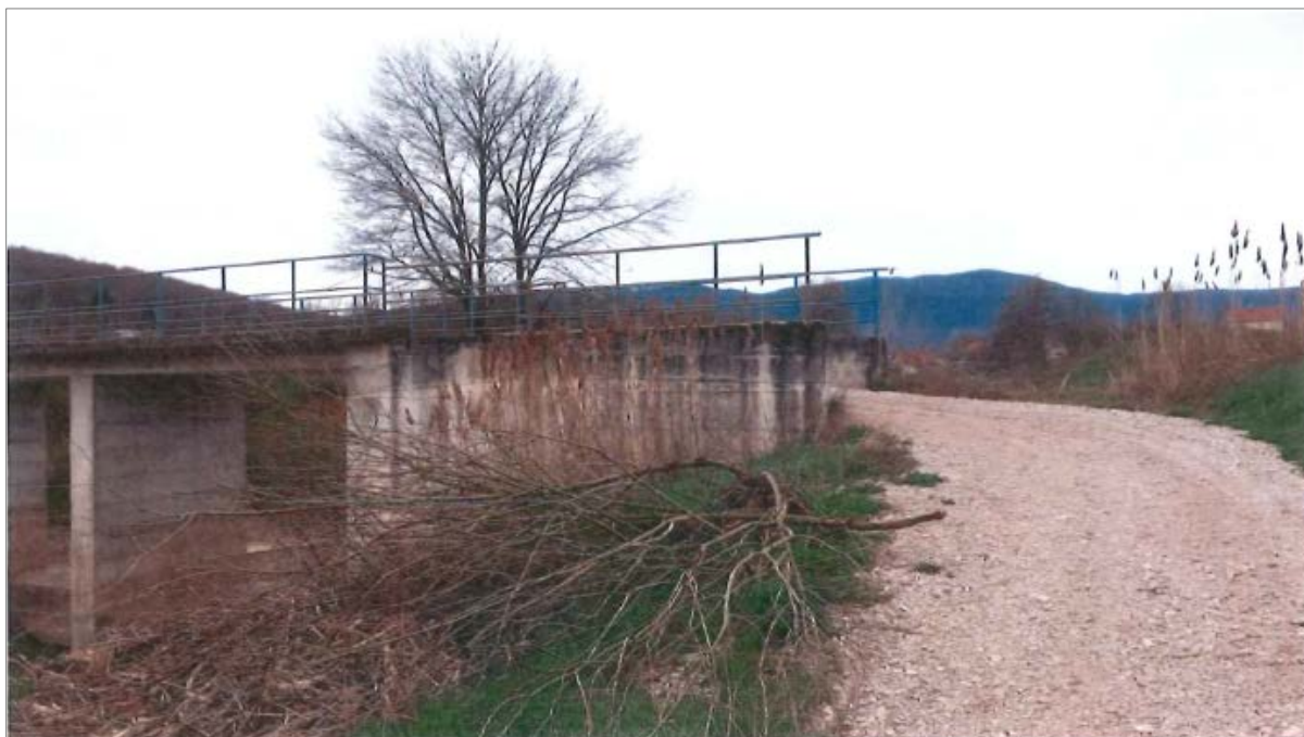
Slika 6. Pristupni put s rampom i krilom koje visinom nije prilagođeno okolnom terenu
