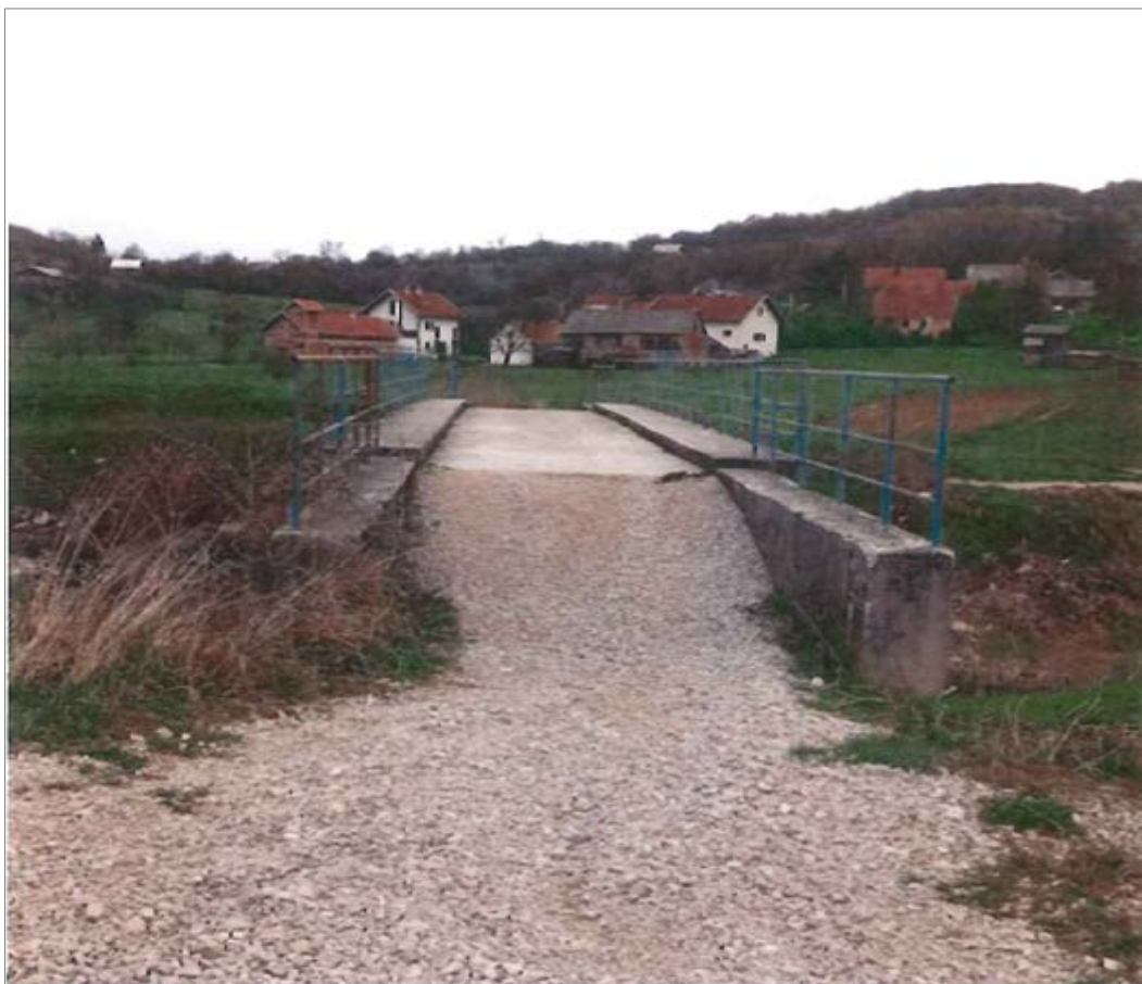
Slika 8. Kolni prijelaz i krila koja nisu prilagođena okolnom terenu (pogled s lijeve obale)
