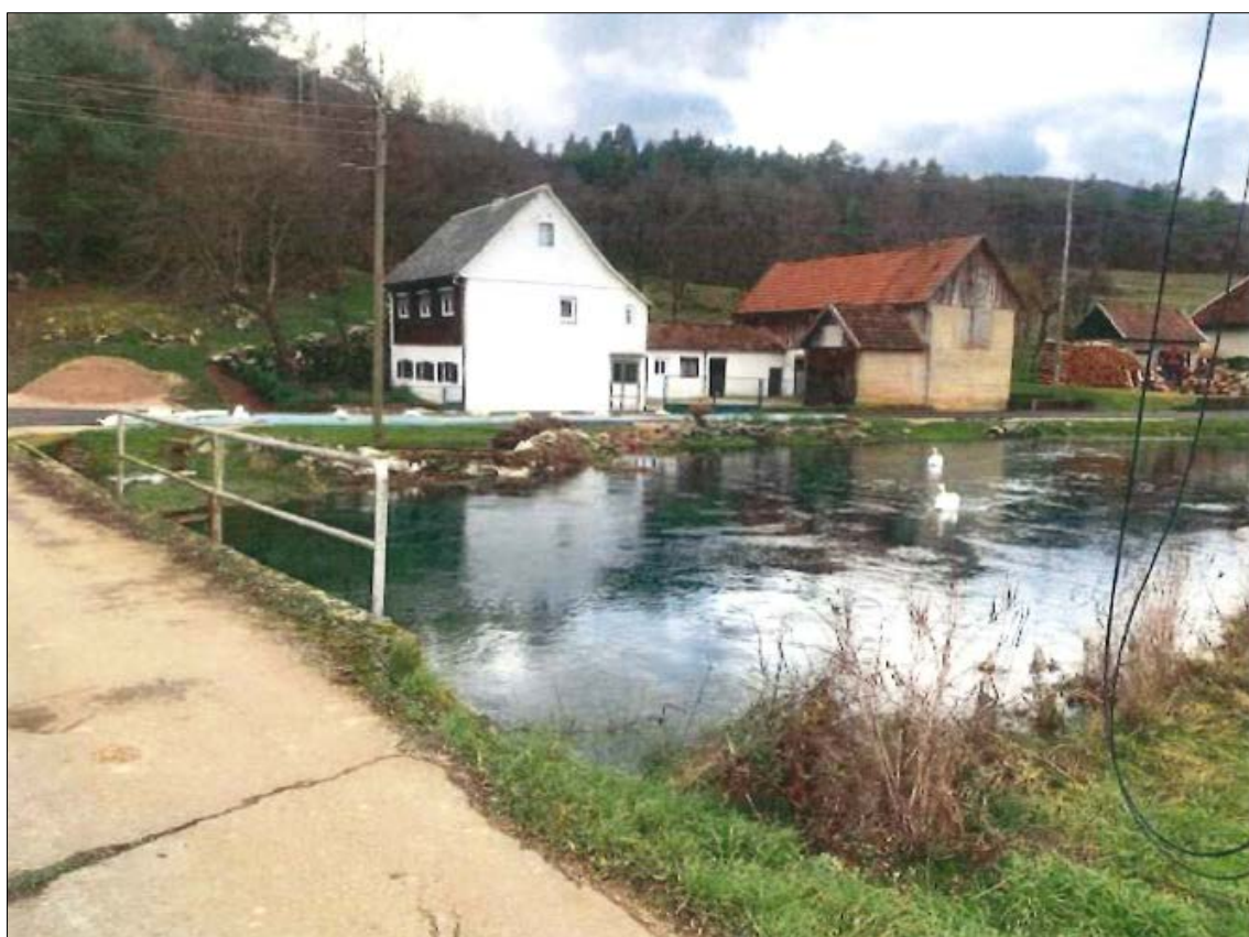
Slika 8. Postojeće stanje terena na poziciji 5 (Izvor: Projektni zadatak: Regulacija vodotoka Kostelka, Hrvatske vode, siječanj 2024. godine)
