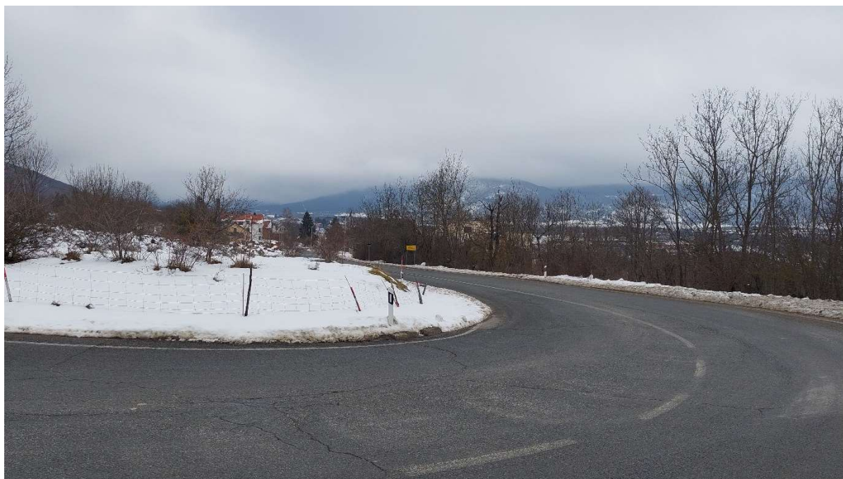
Slika 1.4 Pristupna lokalna cesta
