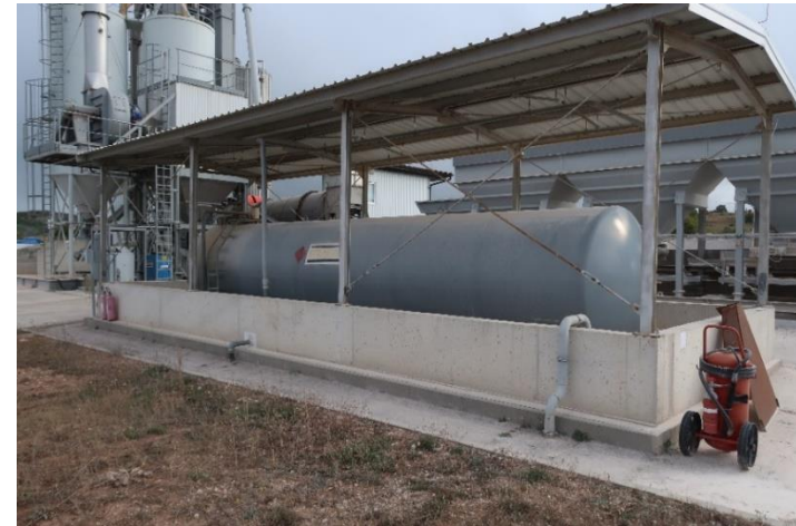
Slika 1./7. Spremnik lož ulja
